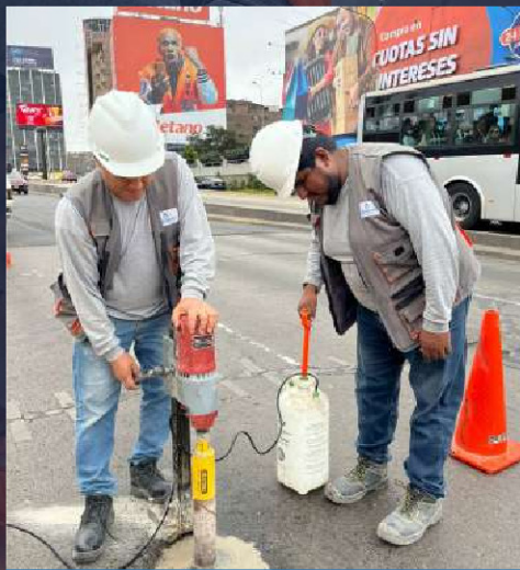
Proyecto: Extracción de diamantina (Asfalto) "Via expresa / Lima"
