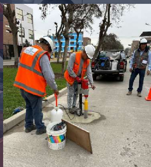
Proyecto: Extracción de Diamantinas Av. San Felipe Comas / Lima
