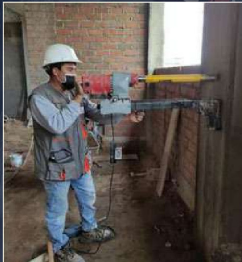
Proyecto: Evaluación estructural de vivienda multifamiliar Ate / Lima / Lima
