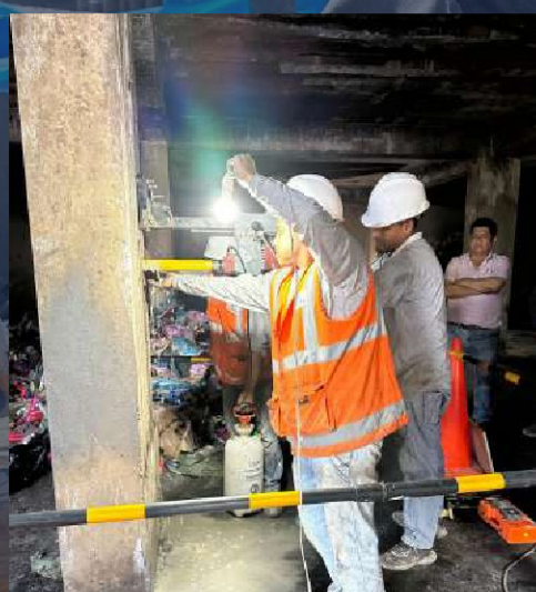
Proyecto: Evaluación Estructural - Almacenes Cercado de Lima / Lima
