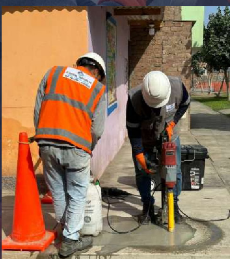
Proyecto: Extracción de Diamantinas Veredas Santa Luisa - Los olivos / Lima
