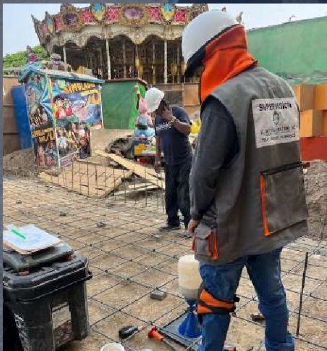
Proyecto: Supervisión de calidad en metro sjl (Densidad de campo)
